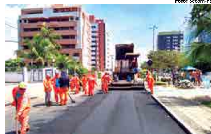
Restauração do trecho em CBUQ, em fase final, tem extensão de 5,8km
